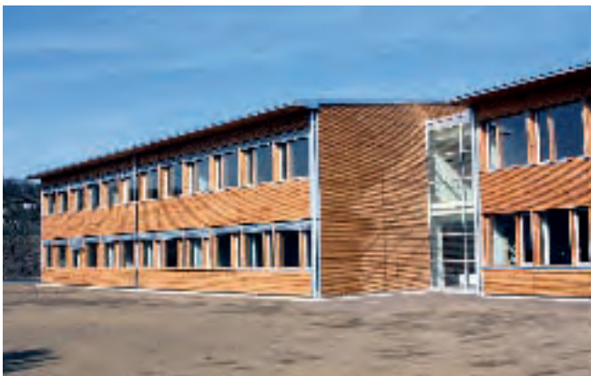
Ansicht von Osten – der moderne Klassengebäudetrakt
