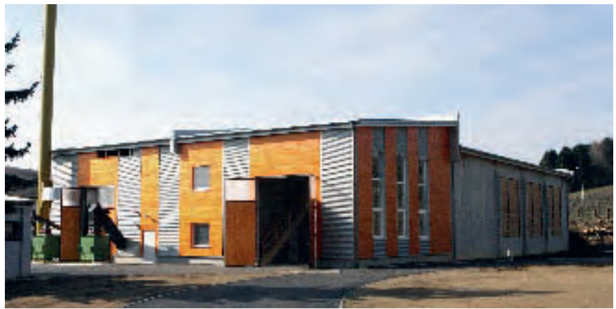
Die neue Biomasseheizanlage mit 1,4 MW Leistung
